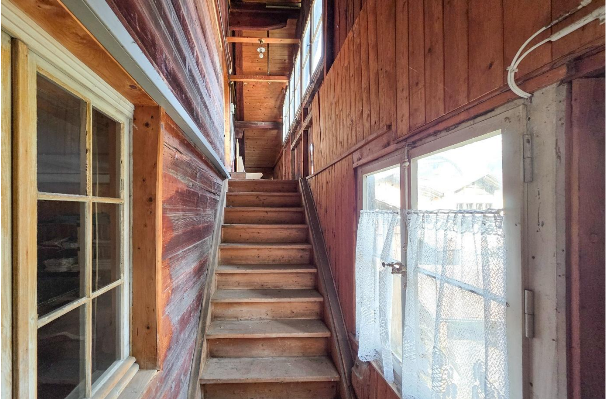
Die Treppe ins Dachgeschoss
