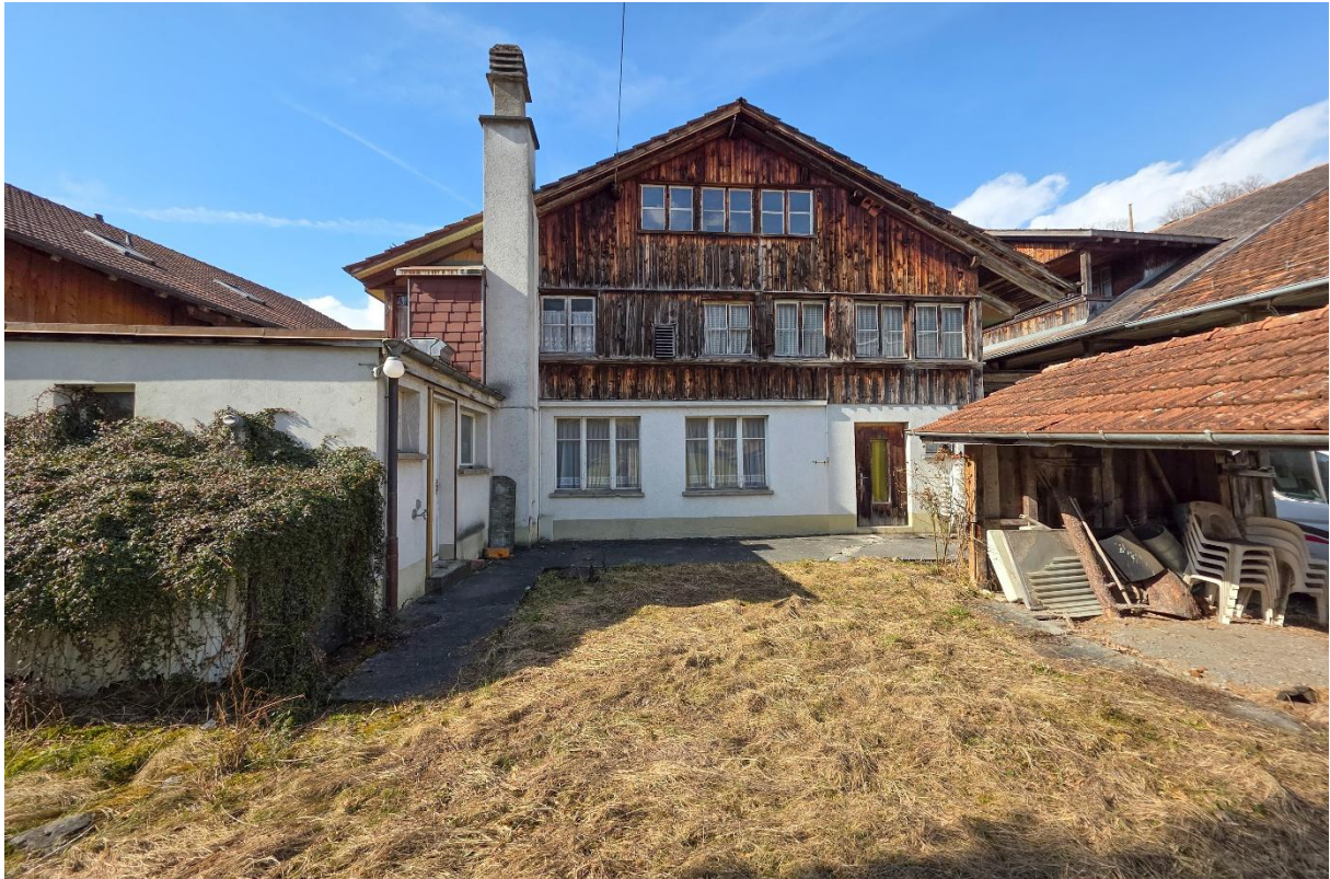
Die Aussenansichten der Liegenschaft...
