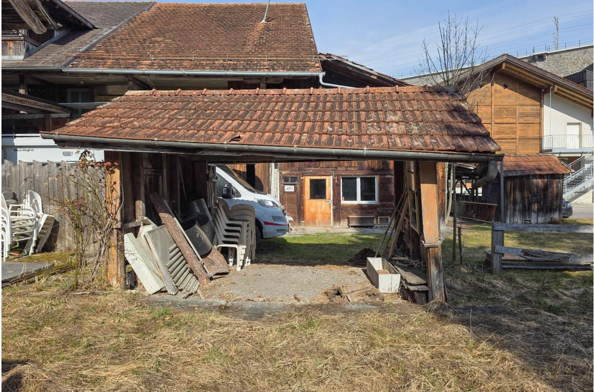
Das Nebengebäude Nr. 1 - Unterstand
