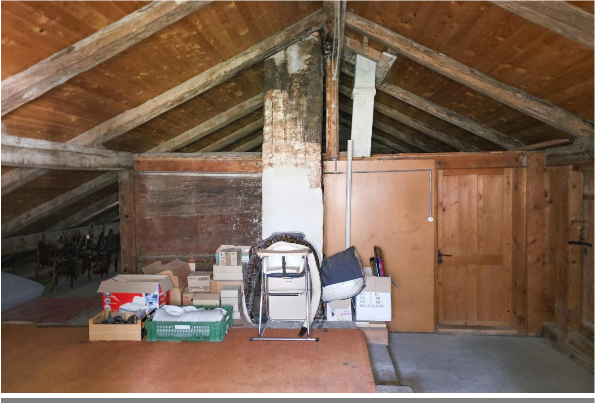
Der Estrich mit zwei weiteren Zimmern
