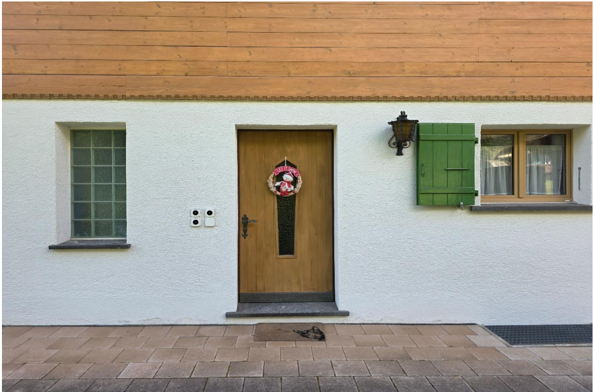
Der Zugang in das Zweifamilienhaus
