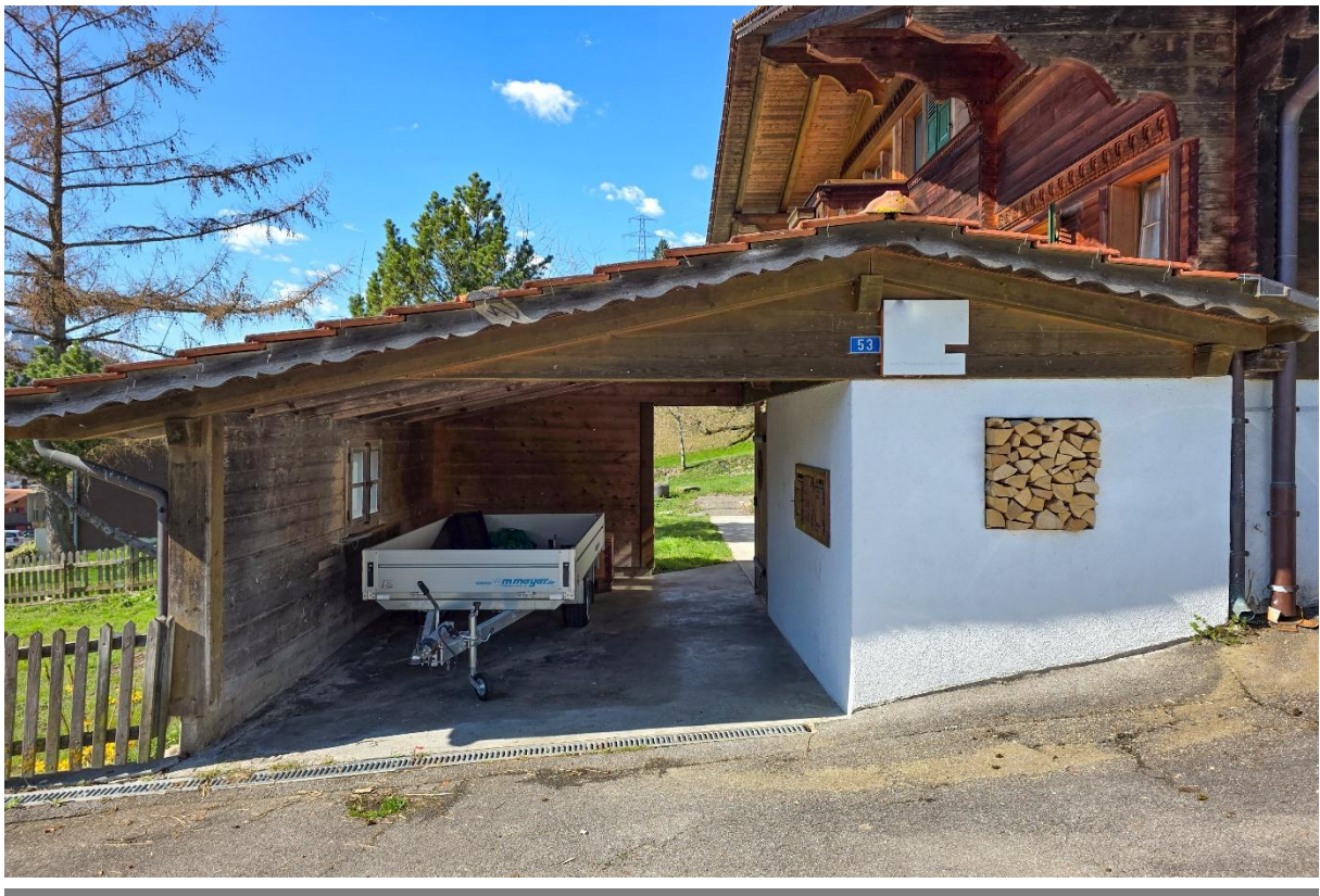
Der Zugang zum Haus mit gedecktem Autounterstand
