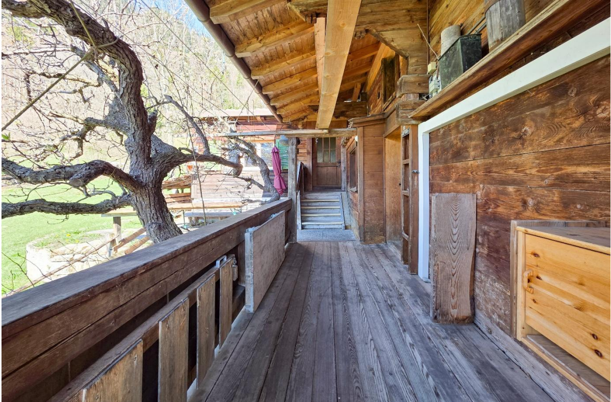
Die gedeckte Laube mit dem Zugang zu den Wohnungen und der Werkstatt
