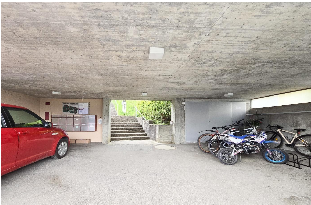
Der gedeckte Velounterstand mit Briefkästen und Treppenaufstieg zur Überbauung
