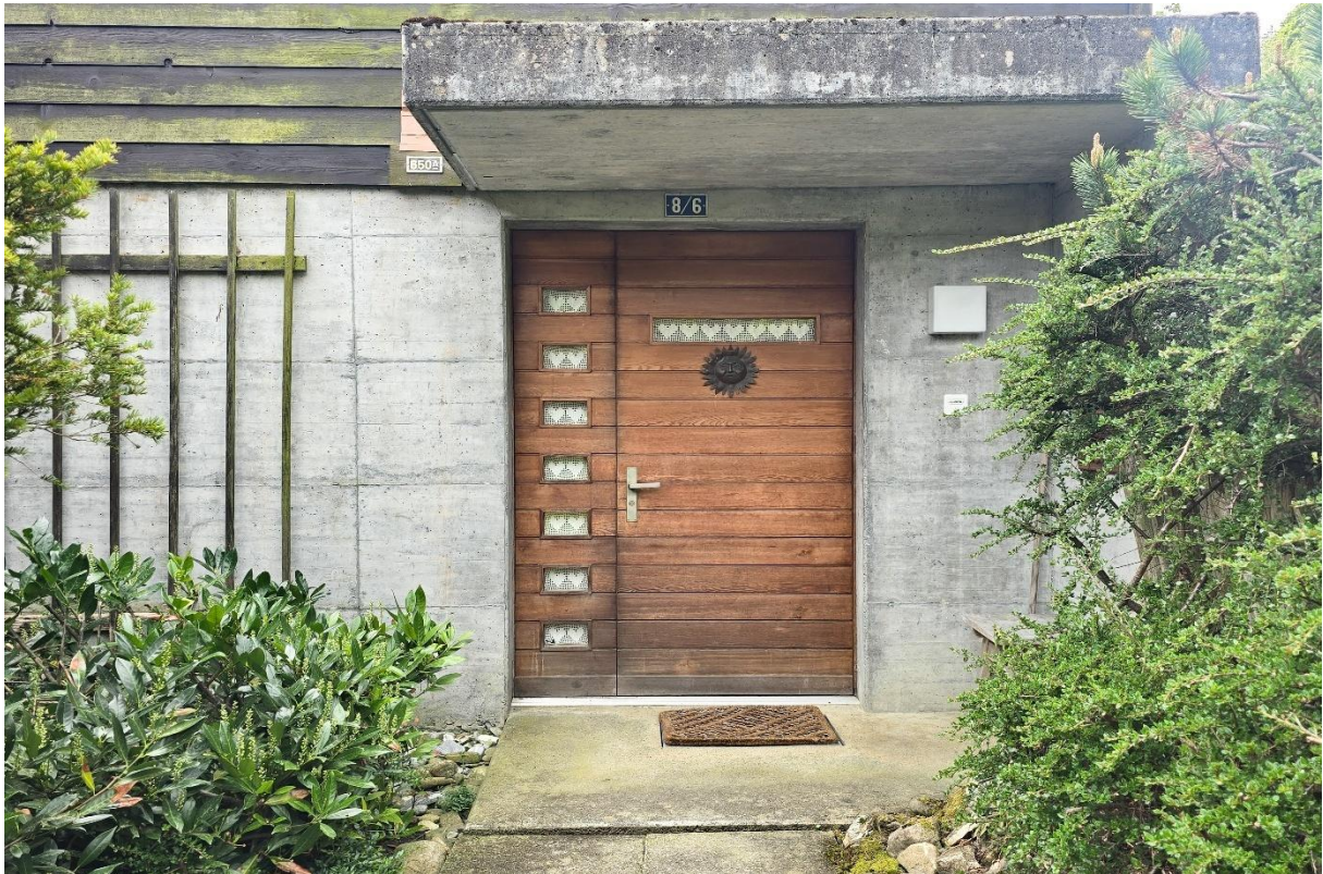
Der gedeckte Eingangsbereich
