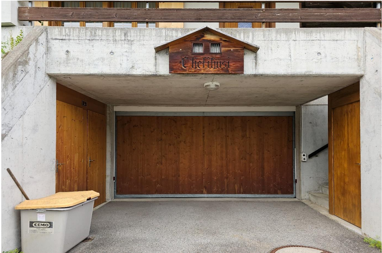
Die Einstellhalle mit einem dazugehörigen Autoabstellplatz
