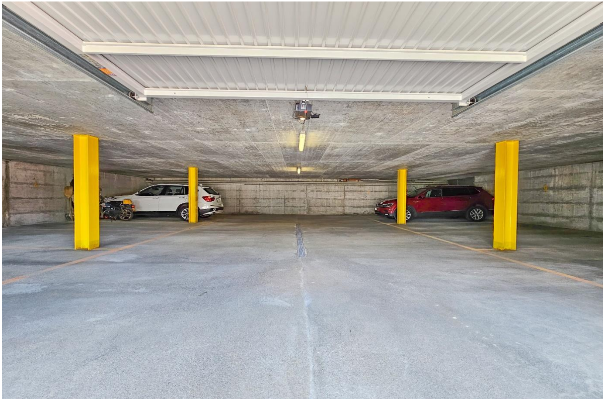
Die Einstellhalle mit einem Abstellplatz und einem weiteren Parkplatz vor der Halle
