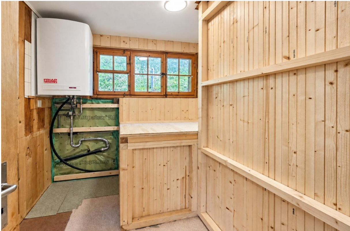
Der Abstellraum/ Technikraum im OG
