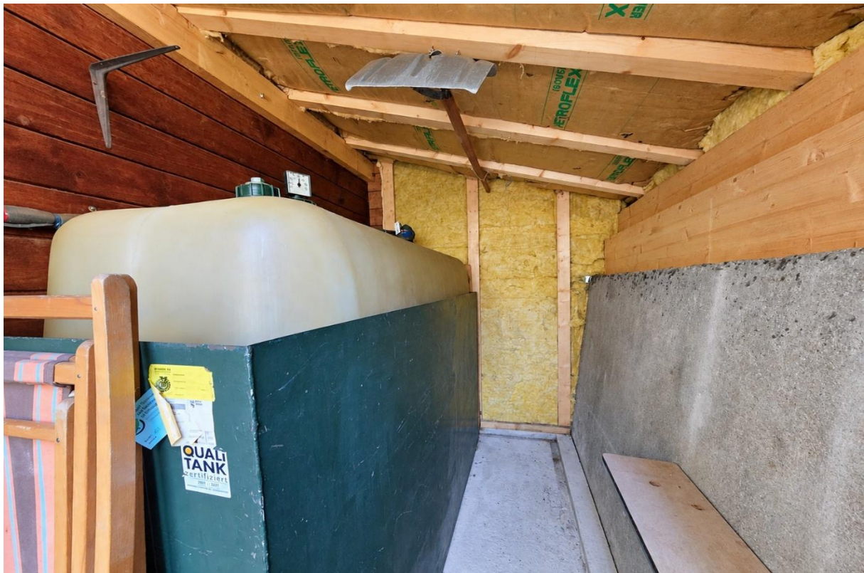
Der separate Kellerraum mit Öltank
