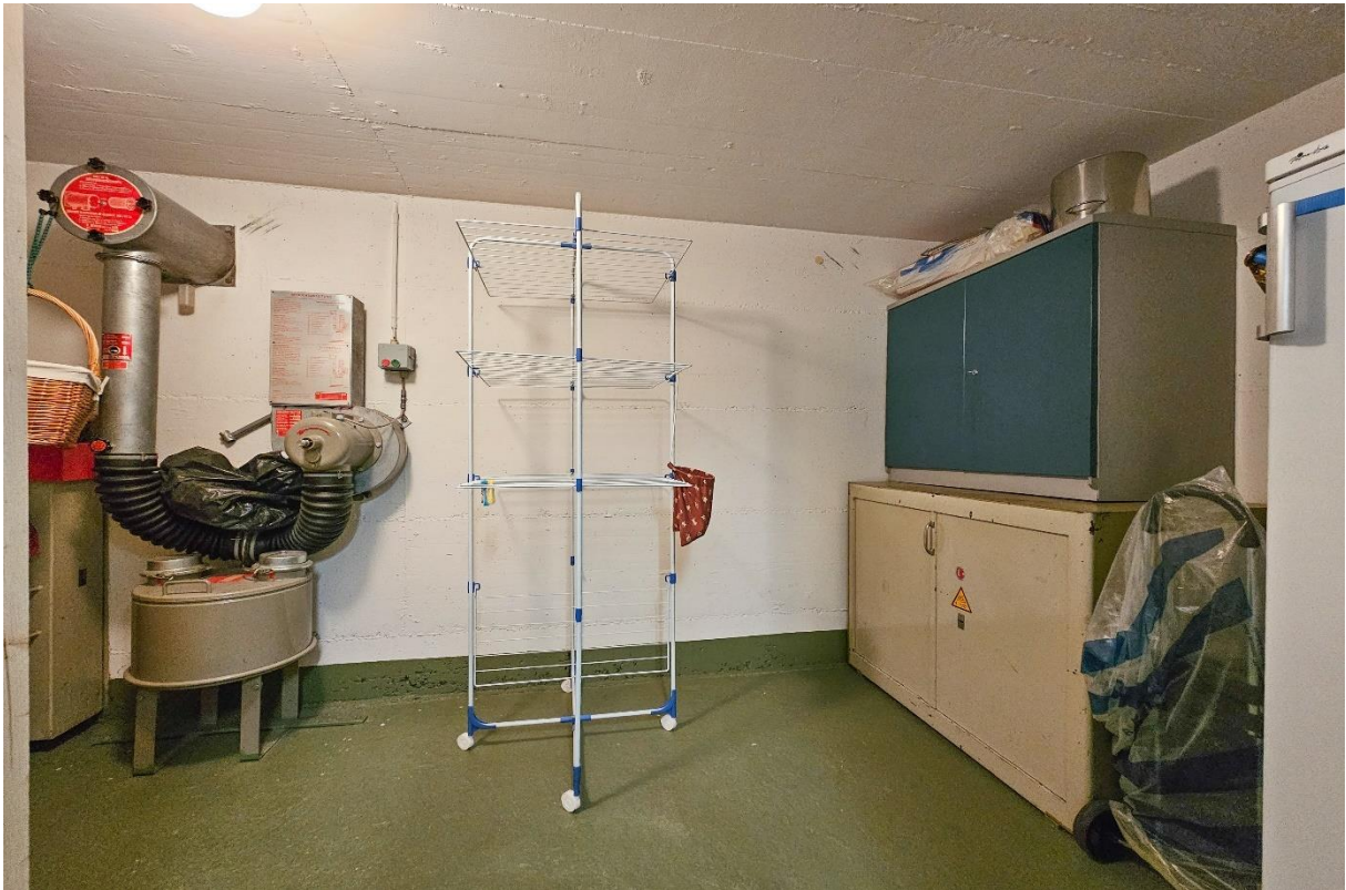
Die gemeinschaftlichen Nebenräume mit Luftschutzkeller, Waschküche und der Heizung
