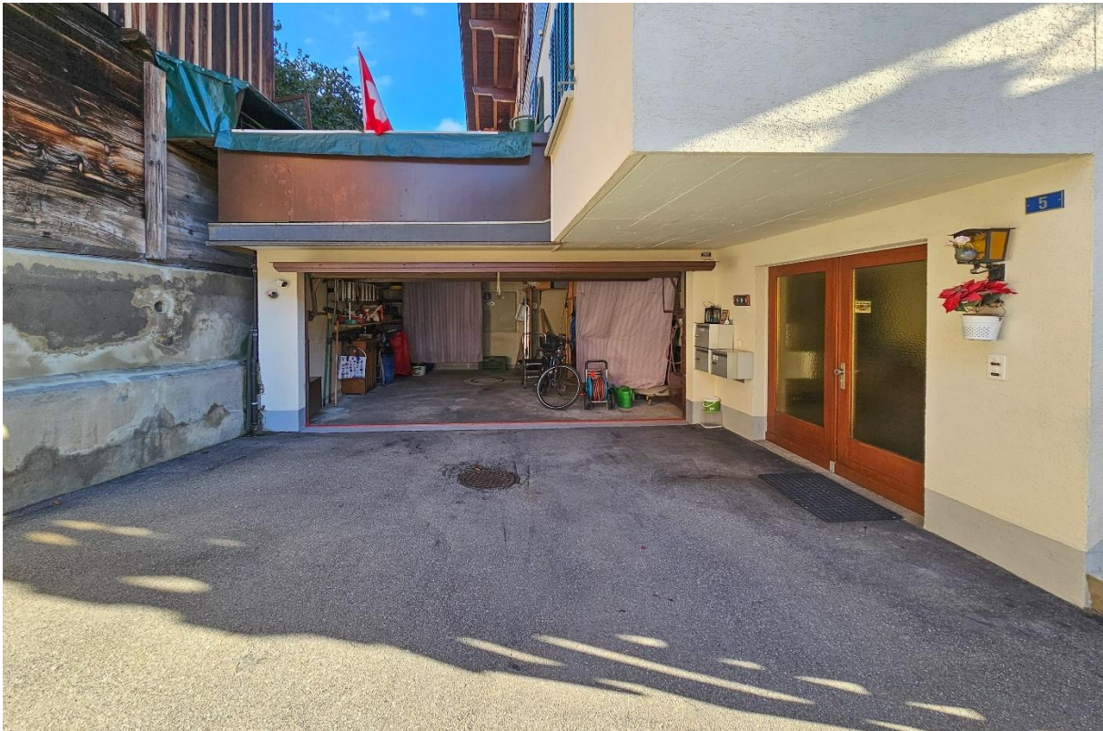
Der Vorplatz mit der Doppelgarage und der Eingang in das Wohnhaus
