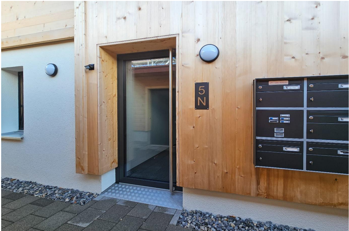
Der direkte Zugang zur Wohnung mit dem Vorraum und Treppenhaus - Musterfoto
