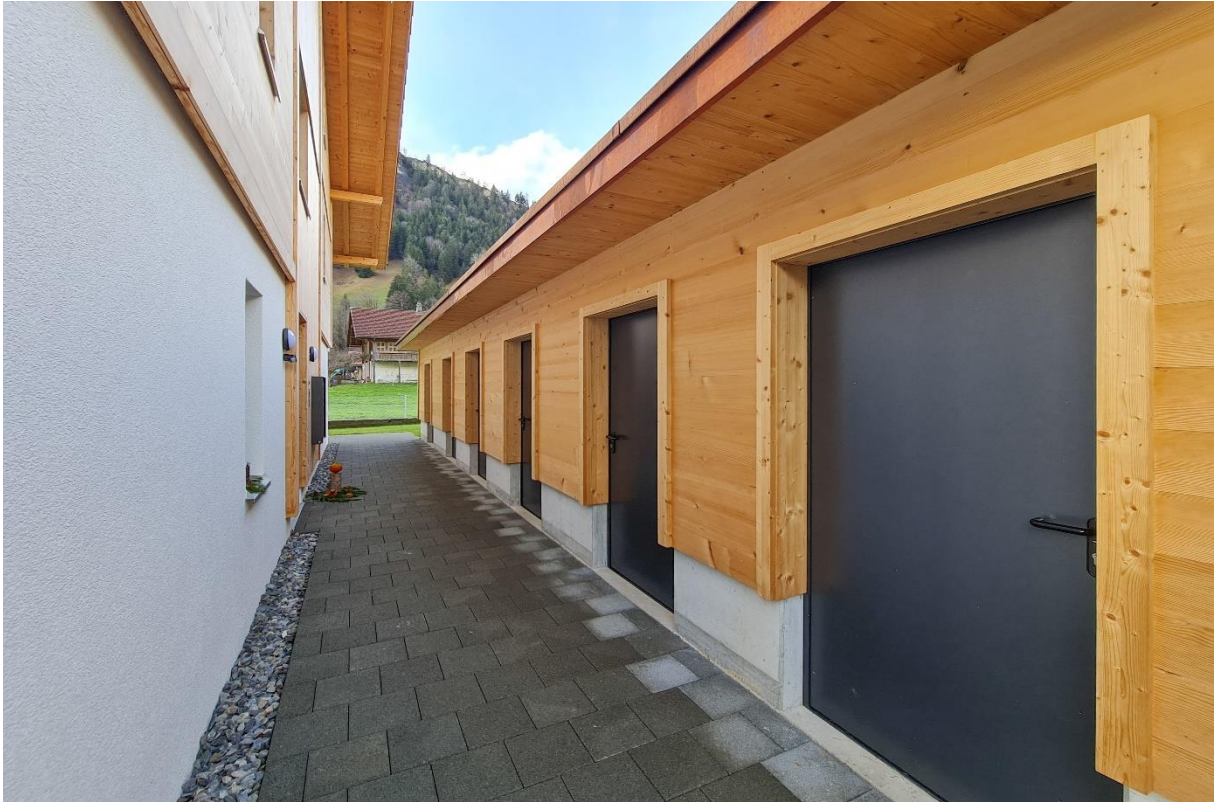
Der Nebenraum mit Licht und Stromanschluss...- Musterfoto
